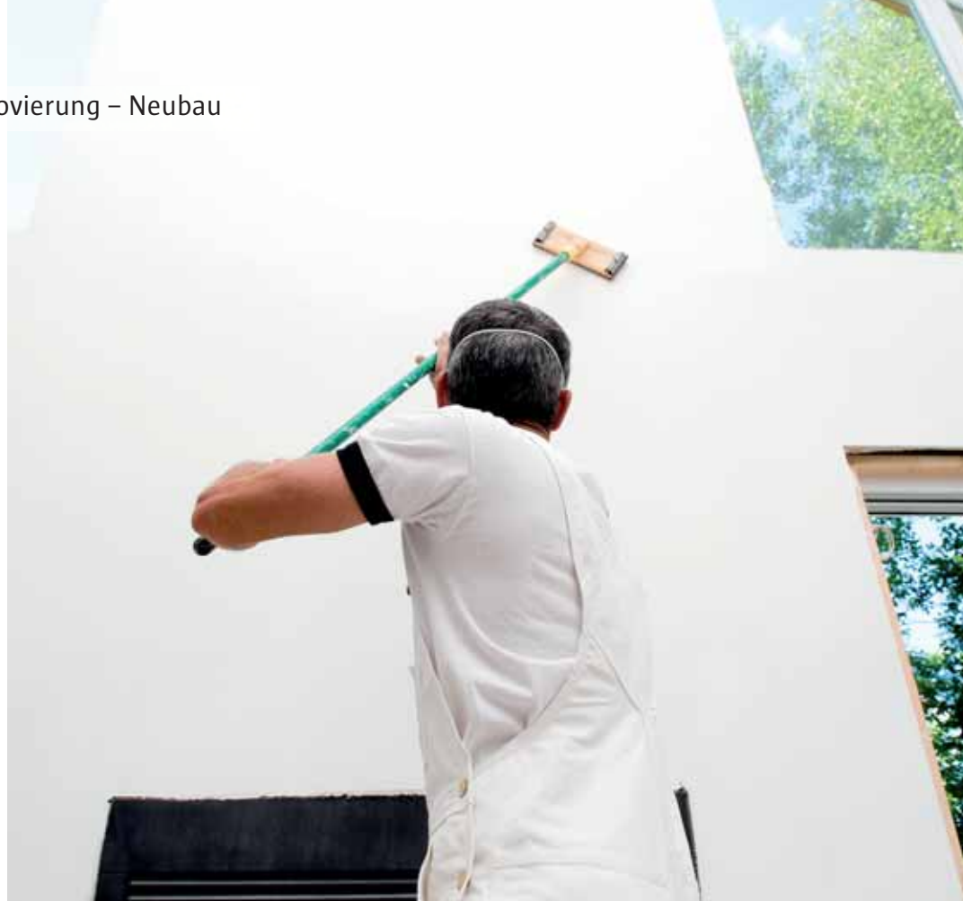
Einen besonders hohen Stellenwert nimmt die Sanierungsförderung in Wien (30 Prozent der Förderausgaben), der Steiermark (28 Prozent) und in Niederösterreich (23 Prozent) ein.
